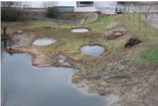
Aushub von Kleingewässern
